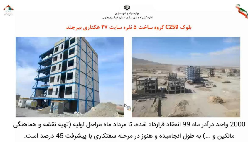
شکل ۲۴: آپارتمان‌های نیمه‌تمام پروژه خراسان جنوبی
