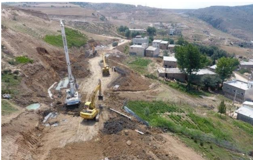
اجرای شمع‌های بتنی برای تثبیت بستر روستا
