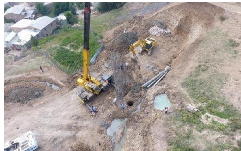
اجرای شمع‌های بتنی برای تثبیت بستر روستا
