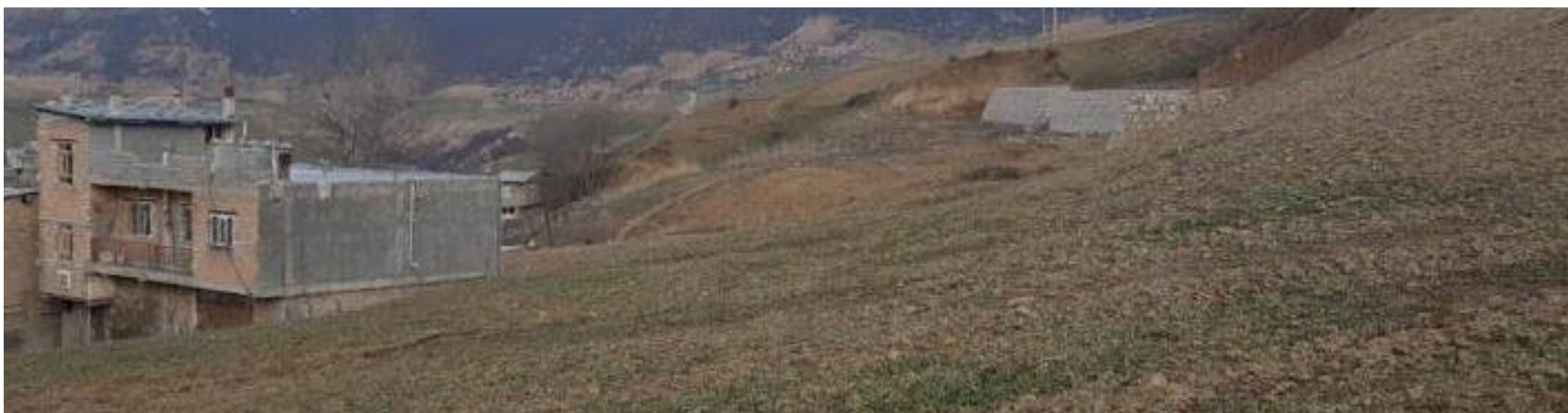
دیواره اجراشده در محل شمع‌ها، دی ۱۴۰۲
